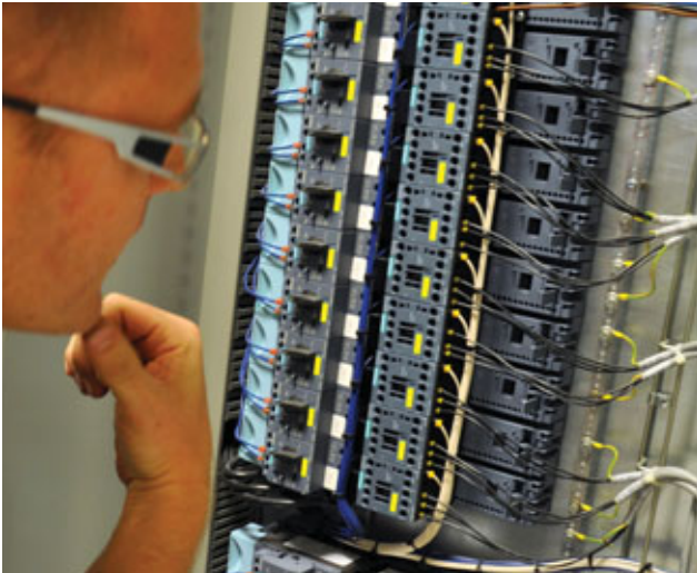
Gert Kiil var overrasket over, hvor nemt og smertefrit det gik at pille en motorstyring ud af tavlen – og sætte den tilbage på plads.
