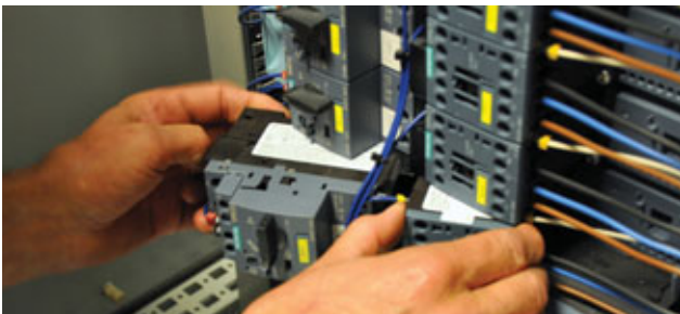
Først fjernes den komponent, der skaber forbindelse til den enkelte enhed. Derefter kan enheden fjernes, uden at anlægget stoppes, og uden det berører de andre enheder på skinnen. En ny enhed sættes i og kobles til uden afbrydelser.
